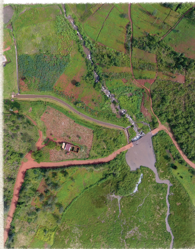
Photo : Micro-centrale hydroélectrique de Niyabikéré (prov. Karusi)
