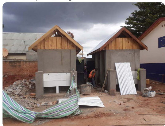
Construction de sanitaire dans une EPP
