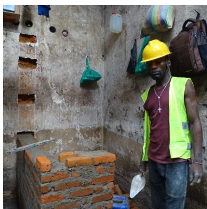
Toilette en construction à l'intérieur des cellules
