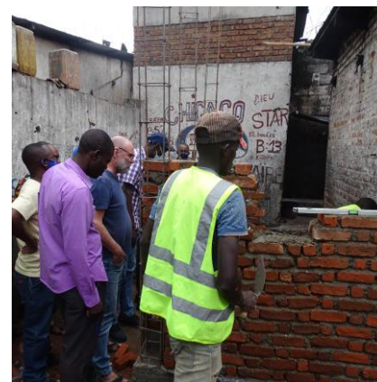
Douches en cours de réhabilitation
