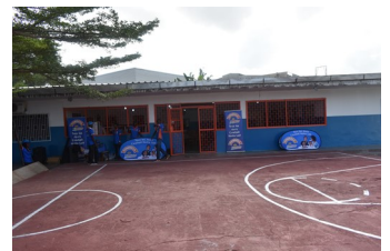
Une vue du centre après les travaux rue.
