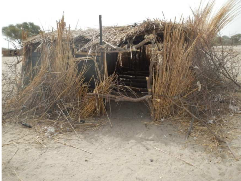
Photo 1 : hangar servant de salle de classe à l'école de Makarati
